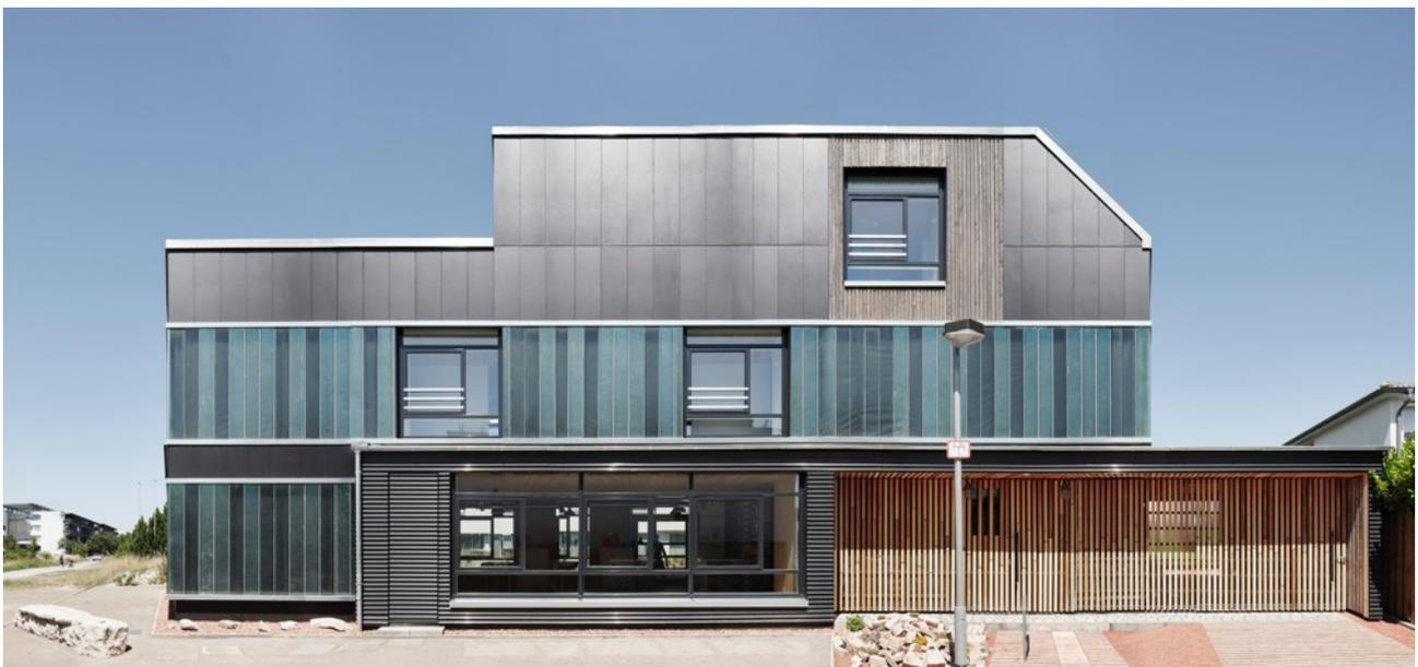
VHF als Wertstofflager: 90% der Fassade des Recyclinghaus Hannover bestehen aus gebrauchten Materialien. Das innovative Pilot- und Forschungsprojekt von Cityförster Architekten wurde mit einem Sonderpreis für Nachhaltigkeit beim Deutschen Fassadenpreis 2020 für VHF ausgezeichnet. Foto: Olaf Mahlstedt
